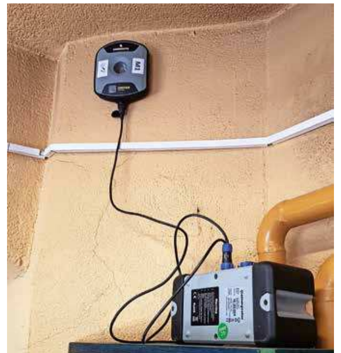
SLIKA 5b: Mjerni uređaj postavljen je na nosivi zid građevine
