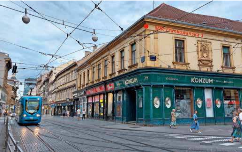
SLIKA 5a: Mjerna lokacija na 2. etaži zgrade (Frankopanska 1)
