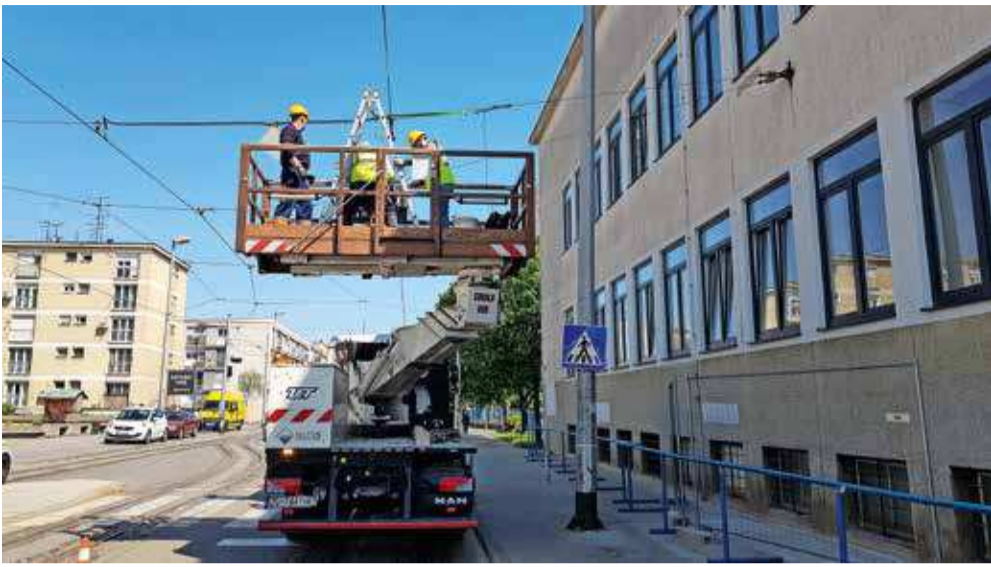
SLIKA 1: Ispitivanje nosivosti prihvata kontaktne mreže na fasadi građevine
