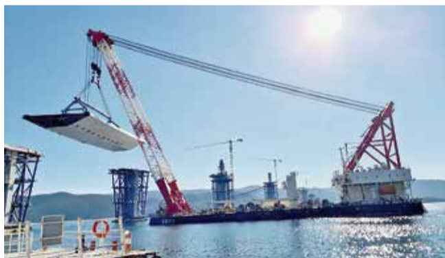
Montaža elemenata pristupnih raspona
