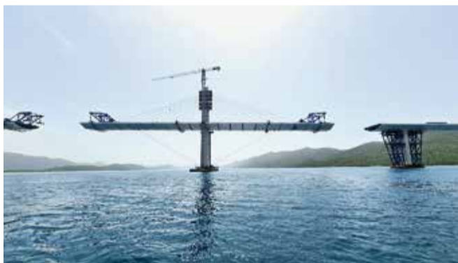
Montaža rasponskog sklopa
