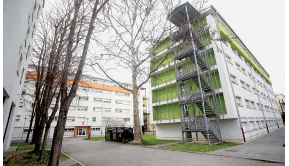
Studentski dom Cvjetno naselje primio je građane čiji su domovi teško oštećeni Foto: FAH/POOL
